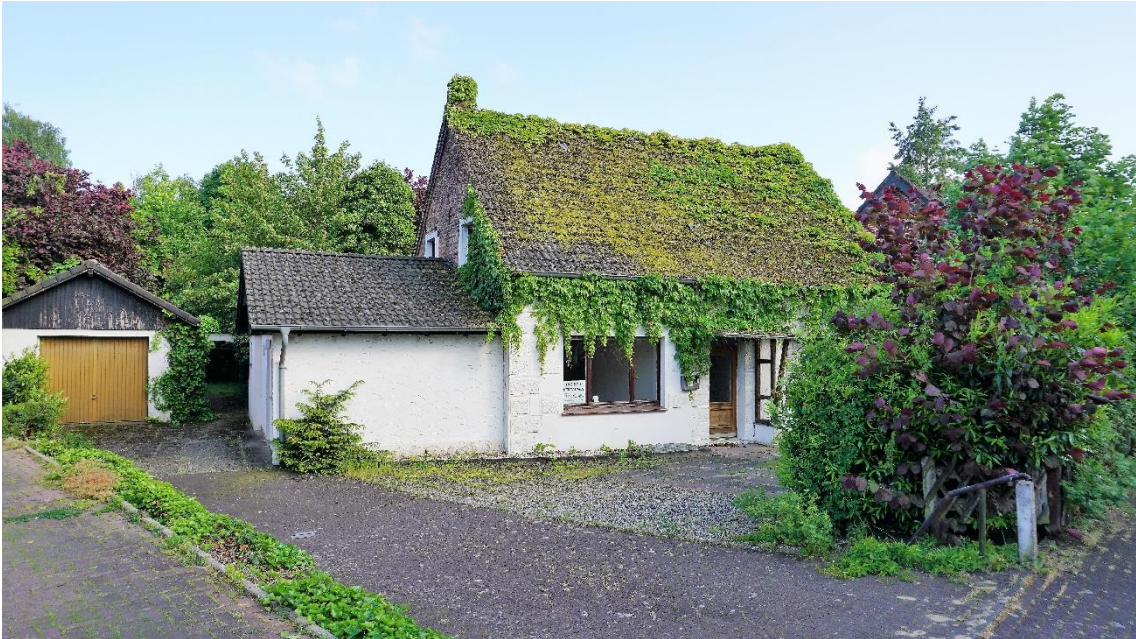
Seitenansicht mit Garageneinfahrt
