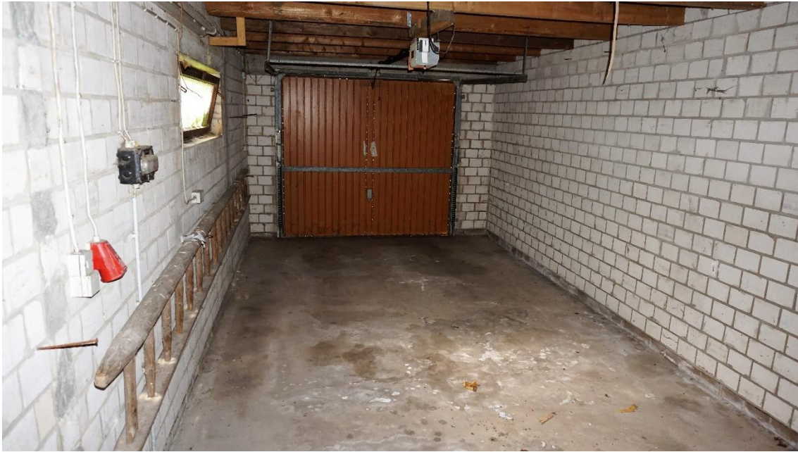
Garage mit Elektroantrieb
