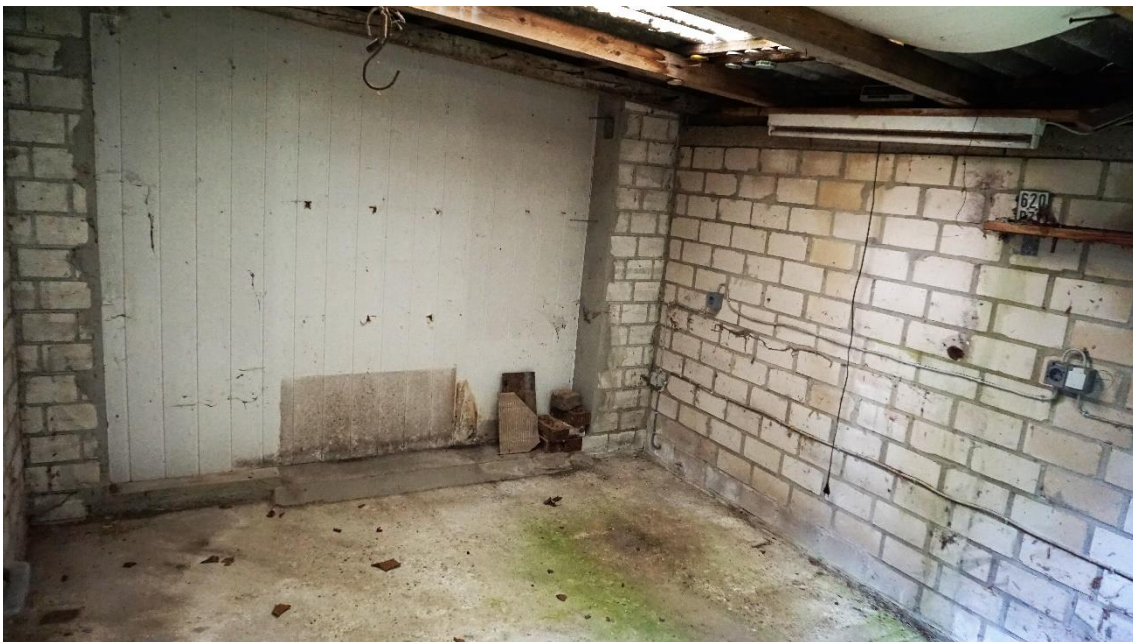
Lagerraum hinter der Garage 02
