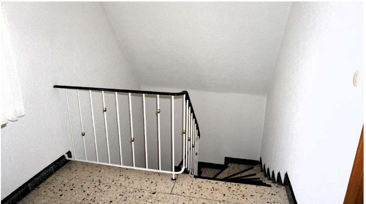
Treppenhaus Obergeschoss, Ansicht 02
